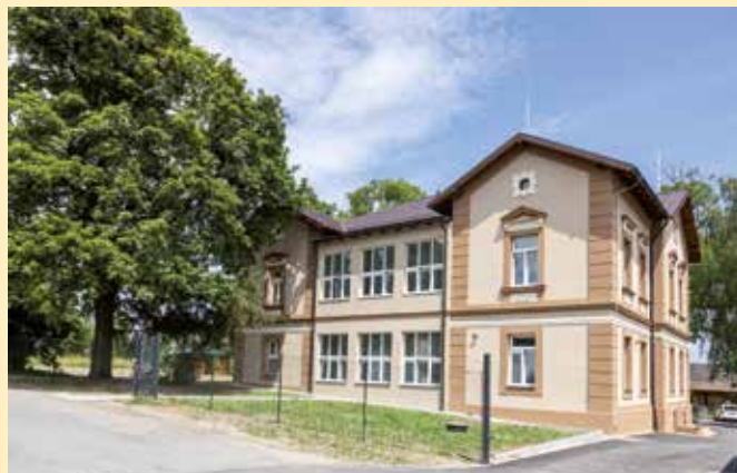
Nově zrekonstruovaná budova Domova pro seniory v Suchdolu nad Odrou na Novojičínku
